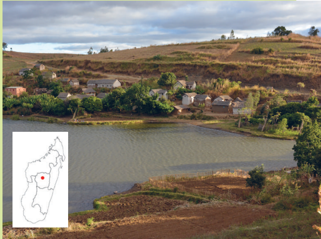
Der Fluss Kotombolo wird zwei lokal produzierte Turbinen mit je 30kW mit Wasser speisen. (Foto: D. Schneider / CEAS)
