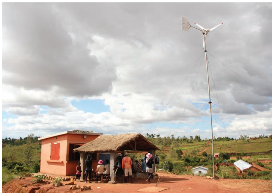
Das Dorfkomitee von Ambohitsilaizina finanzierte den Bau einer Überdachung, um die BesucherInnen des Energiekiosks vor den Launen des Wetters zu schützen. (Foto: P. Kohler/ CEAS)
