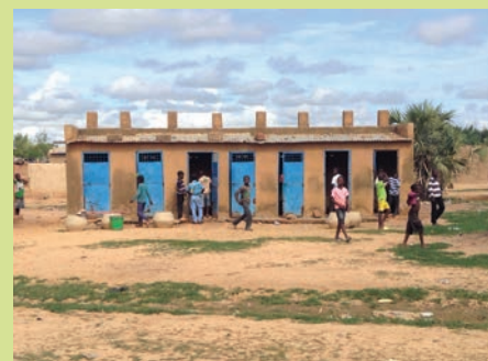
Das Toilettengebäude der Grundschule ist stark reparaturbedürftig.
