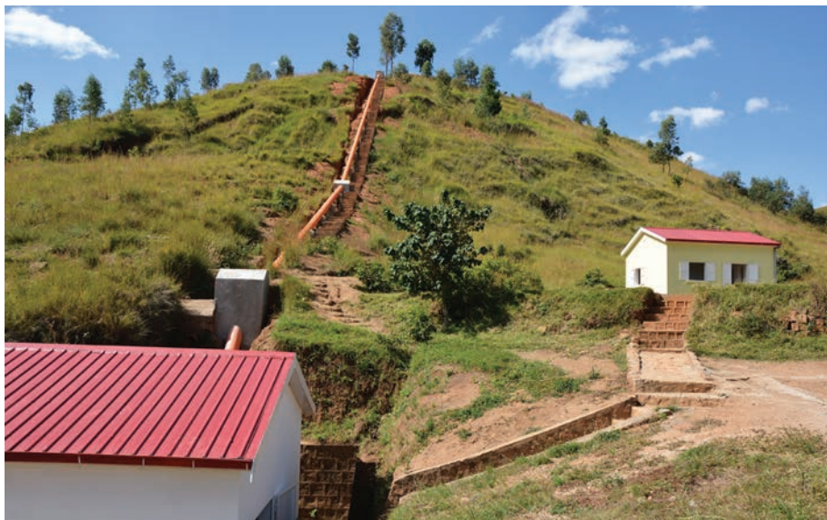
Das Wasserkraftwerk wird 375 Haushalte und ungefähr 20 Kleinbetriebe mit Strom versorgen. (Foto: D. Schneider)
