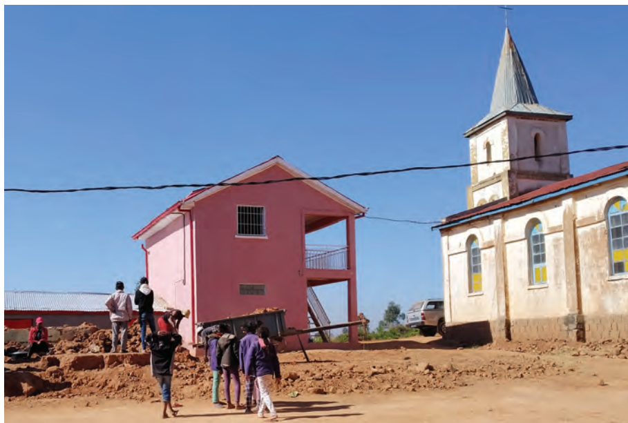
Der Solarkiosk von Ambatomasina versorgt die 800 EinwohnerInnen des Dorfes mit wichtigen Energiedienstleistungen (Fotos: N. Rosoanaivo)
