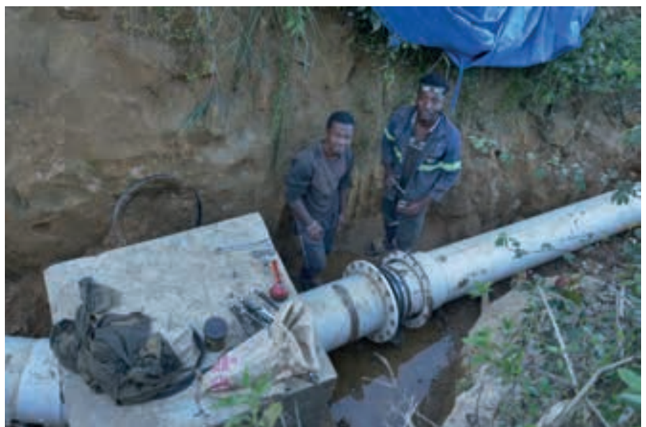
L'installation de la conduite forcée a été réalisée par des entreprises de la région. (photo : Ram's Flare)
