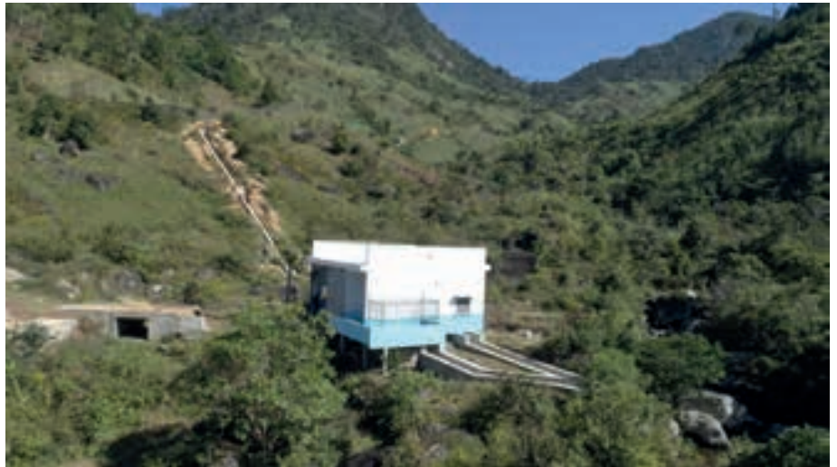
La centrale hydroélectrique de Mandialaza est fin prête à accueillir sa future turbine. (photo : Ram's Flare)
